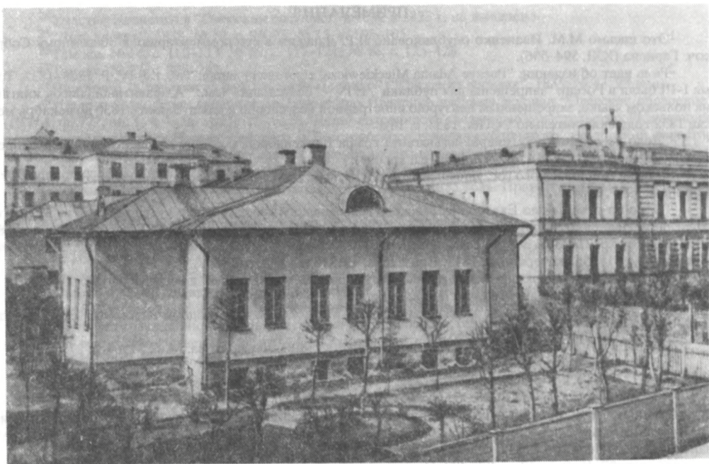
МОСКВА. ЗДАНИЕ ПРЕЧИСТЕНСКОЙ ПОЛИЦЕЙСКОЙ ЧАСТИ В ШТАТНОМ ПЕРЕУЛКЕ (НЫНЕ КРОПОТКИНСКИЙ ПЕР., 23)
